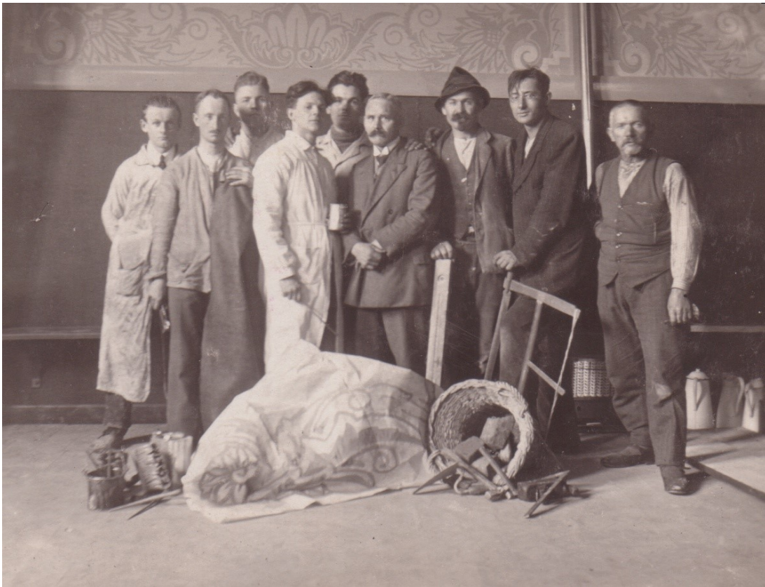
Brüder richten den gemieteten Viaduktbogen am Ehrenfelder Bahnhof in Eigenarbeit her
